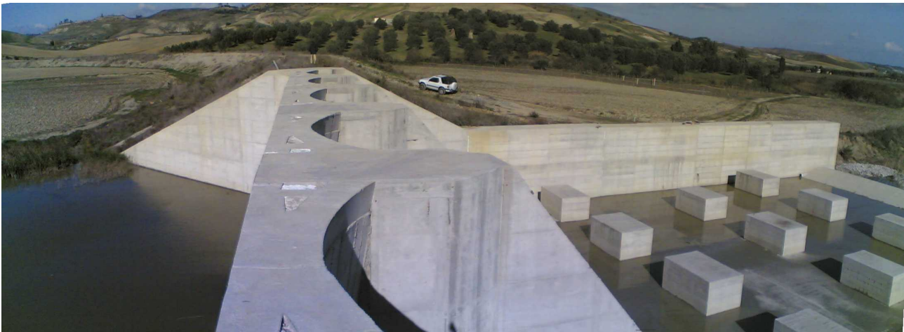
Fig. 2 – Cassa d'espansione di Cacchiavia – Torrente Passovecchio – Realizzata nel 2002 dalla Regione Calabria con fondi stanziati dalla Protezione Civile a seguito dell'alluvione di Crotone del 1996.
