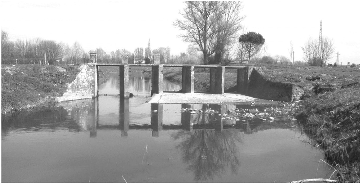
Fig. 3 Vecchie cateratte in località Gattaiola di cui è prevista la demolizione
