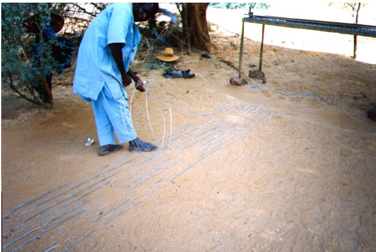
Fig. A.6.3 – Wires cutting
