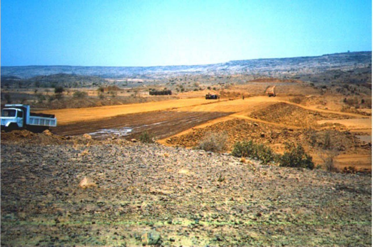
Fig. 4.5 – Fill surface layer watering
