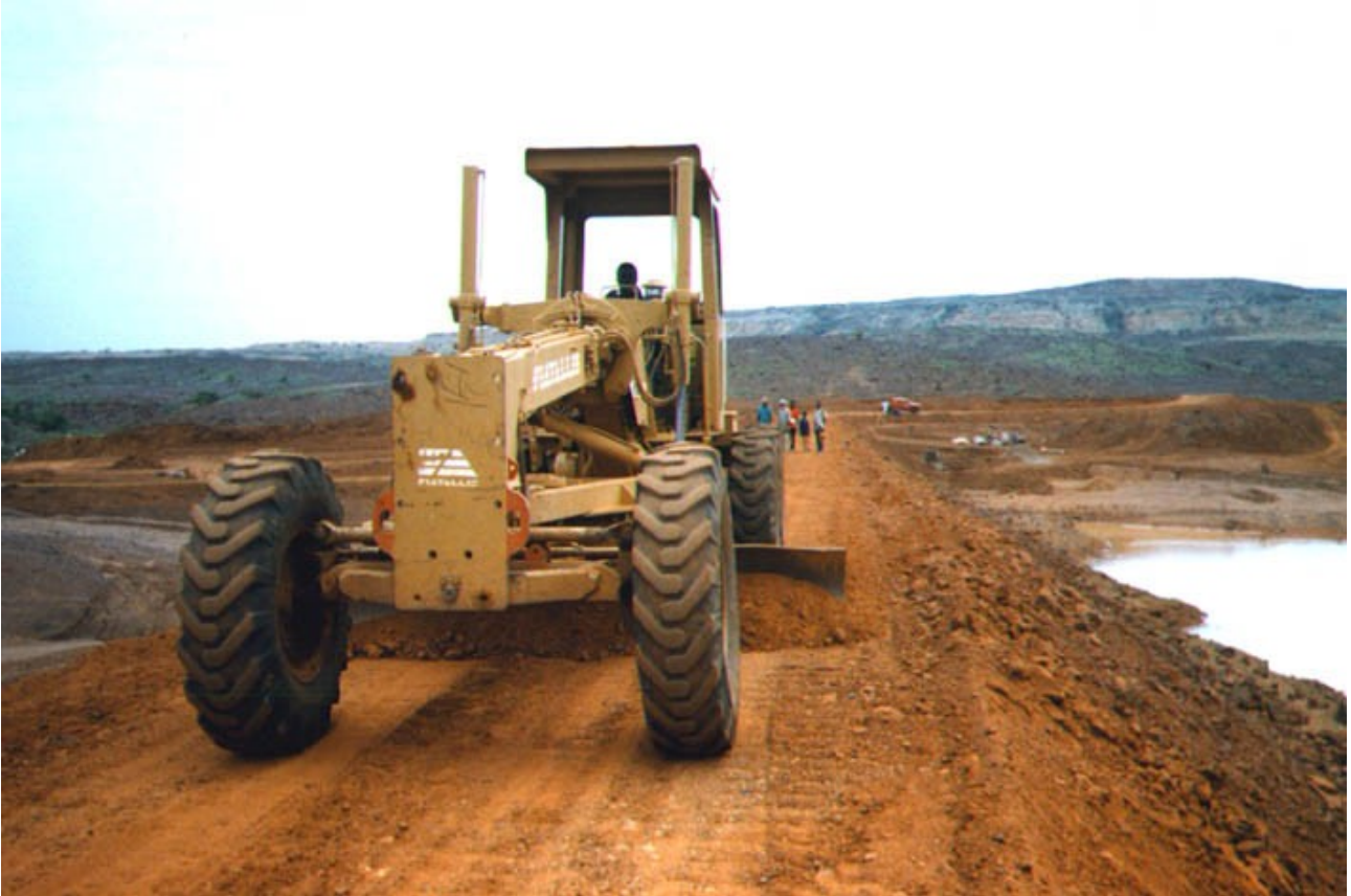
Fig. 4.4 – Fill spreading
